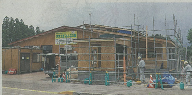
喫茶店の増築工事が進む福祉施設「ささえ愛みんなの家」。今秋のオープンに向けて笠原建設の社員たちが作業に励む＝上越市大貫1
