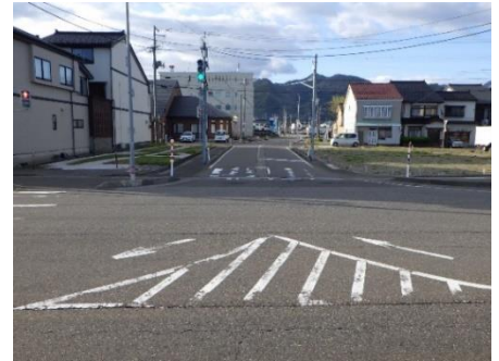
【着手前】 海側より
