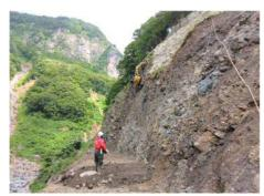
ここは、長野県との県境付近で、姫川左岸の法面を補強 する工事の現場です。傾斜が急で崩れやすい地盤のため、 人力での作業は滑落や落石の危険が伴います。
